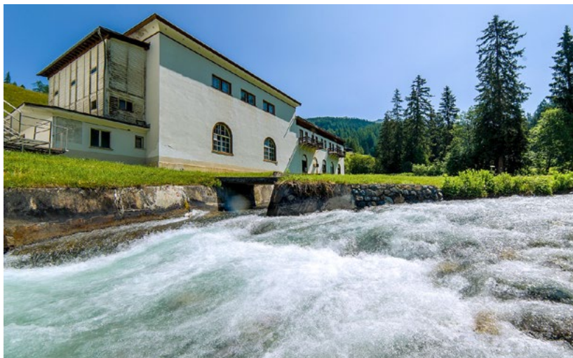
Das Kraftwerk Frauenkirch produziert lokalen Davoser Strom.
