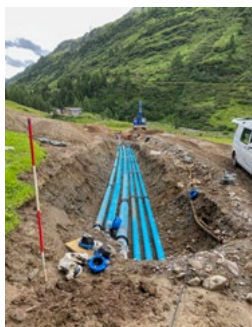
Neu erstellte Transportleitungen vom Quellgebiet in den Hauptsammler Hochflüela (fünf Leitungen) und von dort nach Davos (grösster Durchmesser).
