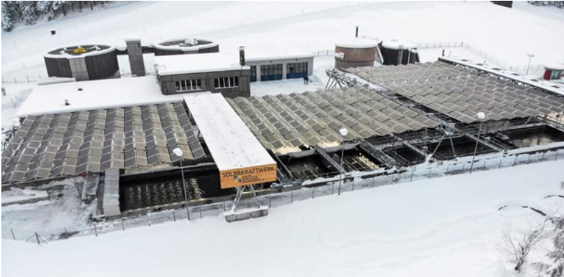
Das ausgefahrene und somit Strom produzierende Solarfaltdach der Abwasserreinigungsanlage Gadenstatt.
