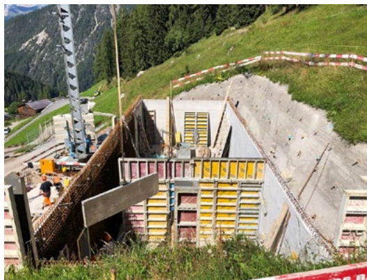
Rohbau des neuen Reservoirs Monstein an der Oberalpstrasse (Inbetriebnahme Ende 2022).
