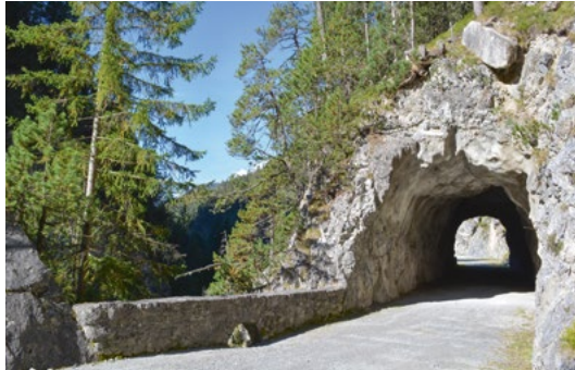
Der Mobilitätsweg führt mit zahlreichen Tunnels und Brücken durch die enge Zügenschlucht.
