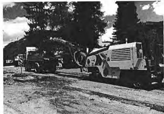
Belagsanierung Bahnhofstrasse Davos Platz
