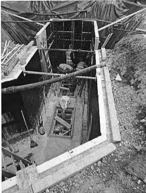
Einsicht in den später verborgenen Zonentrennschacht
