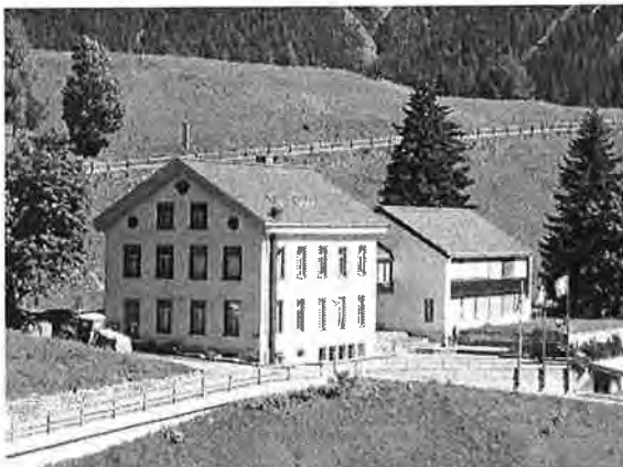
Altes Gemeindehaus Wiesen Dach-, Fenster-, Mauersanierung
