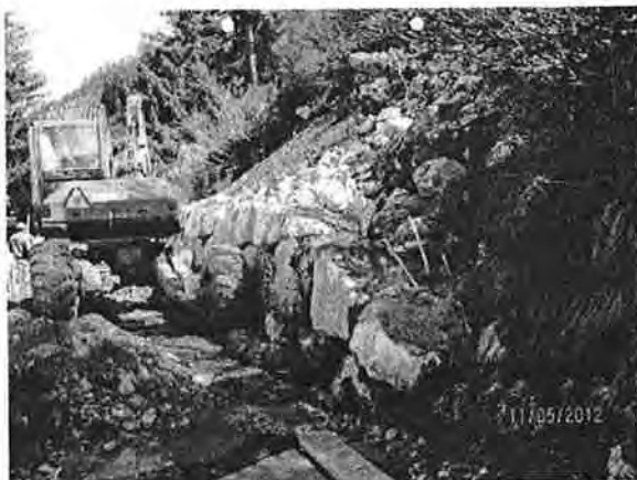
Mauer erstellt mit gesprengten Felsblöcken
