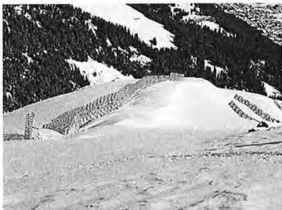
Mit einer Verwehungsverbauung kann die Ablagerung des Triebsschnees beeinflusst werden. Ohne Verwehungsverbauungen wären die Stahlschneebrücken in der rechten Bildhälfte mit Triebsschnee überdeckt und könnten die Schutzfunktion nicht mehr erfüllen.
