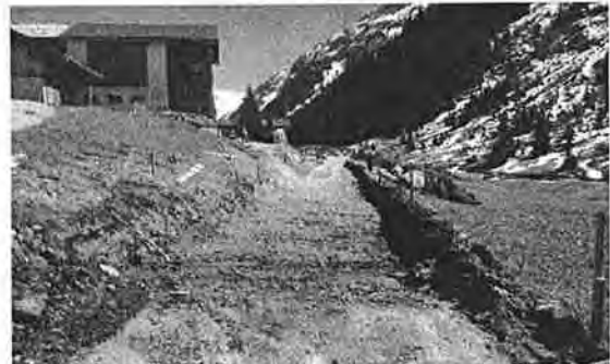
Sanierung Dischmastrasse Abschnitt Chriegmatten bis Teufi
