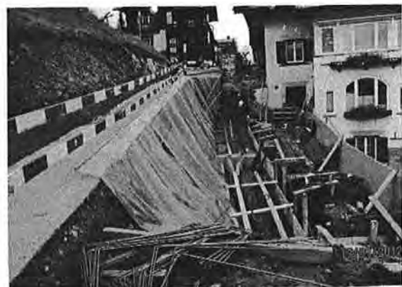
Neubau Stützmauer Salzgäbastrasse
