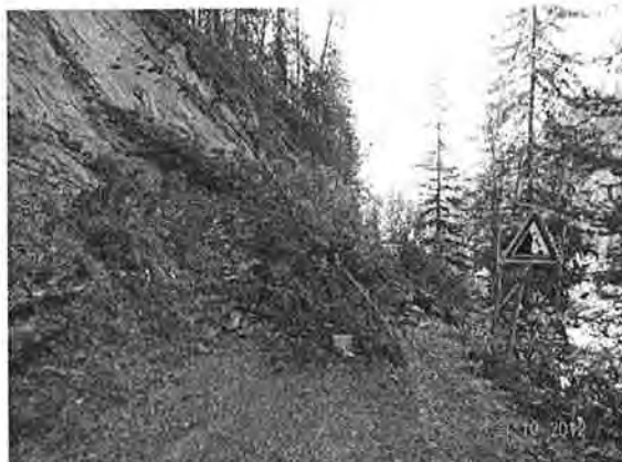
Durch Felssturz verschüttete Zügenstrasse
