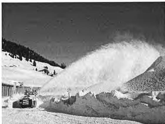
Schleuder beim Davosersee im Einsatz
