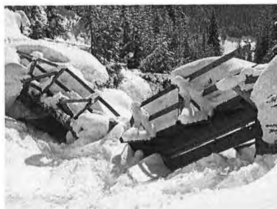
Beschädigte Brücke im Albertitobel
