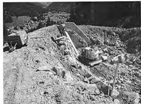
Aufbringen des Erosionsschutzes durch Blocksteine neben dem Auslaufbauwerk
