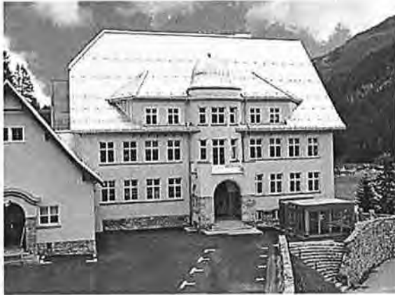
Altes Schulhaus Dorf Umbau PMOD/WRC
