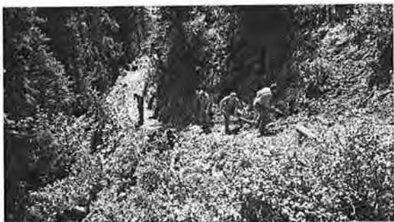
Bau des Wanderweges Stafelalp
