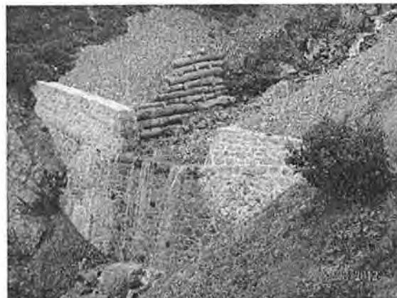
Sanierte Sperre inkl. Leitwerk aus einem Holzkasten
