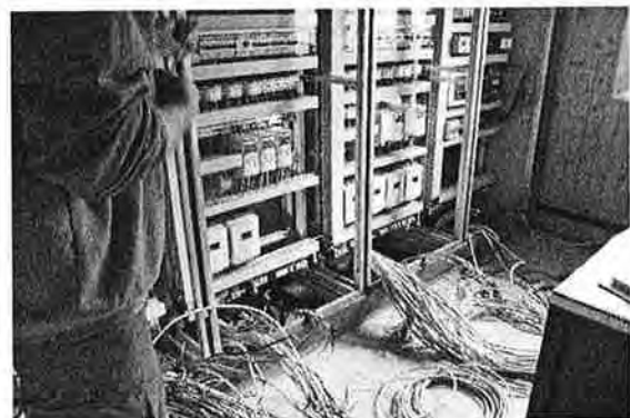
Neue Verkabelung am Steuerschrank
