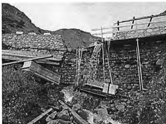
Sperrensanierung in unzugänglichem Gebiet
