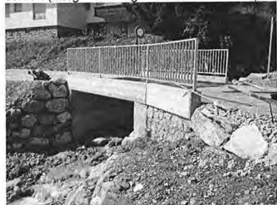
Neu erstellter Durchlass unter der Tschuggenstrasse
