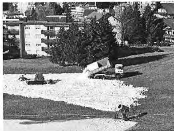
Vorbereitungsarbeiten Davos Nordic
