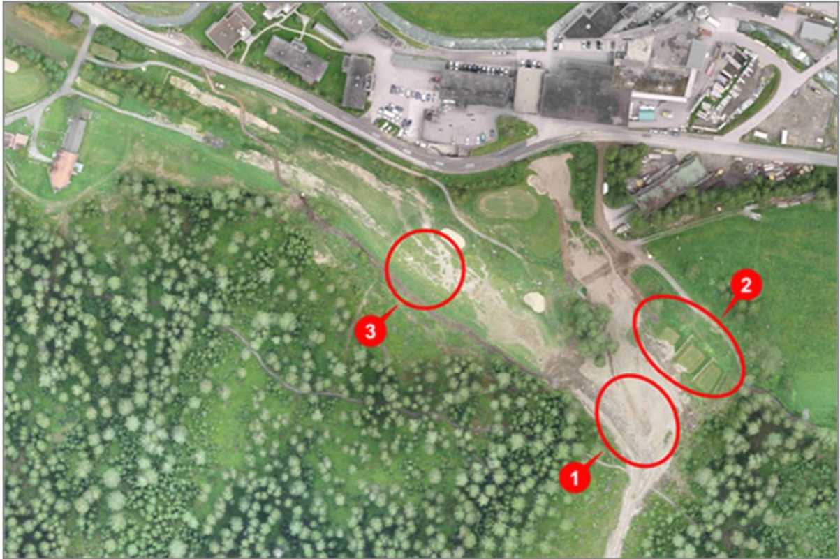
Situation nach dem Murgang: Komplett verschüttetes Green der Bahn 16 (Punkt 1), teilverschütteter Abschlagsbereich der Bahn 17 (Punkt 2) und Standort des provisorisch eingerichteten Greens (Punkt 3).
