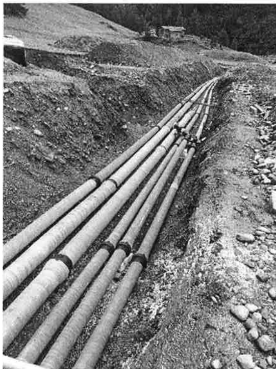
Neue Transportleitungen im Hochlüela
