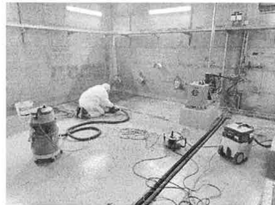
Entfernen der alten Farbe im Rücklaufschlamm-Pumpwerk
