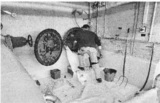
Der Zugang zum Faulraum ist jedesmal eine grosse Herausforderung
