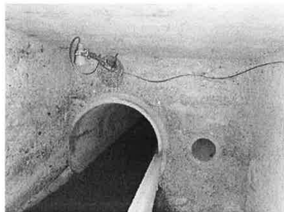
Ansicht einer Hochwasserentlastung
