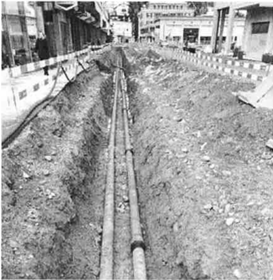
Die neuen Wasserleitungen an der Promenade (im Bild Bereich Arkaden)
