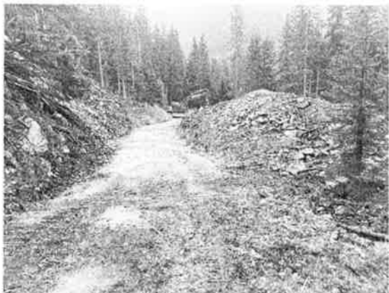
Geräumte Strasse mit talseitigem Schutzdamm
