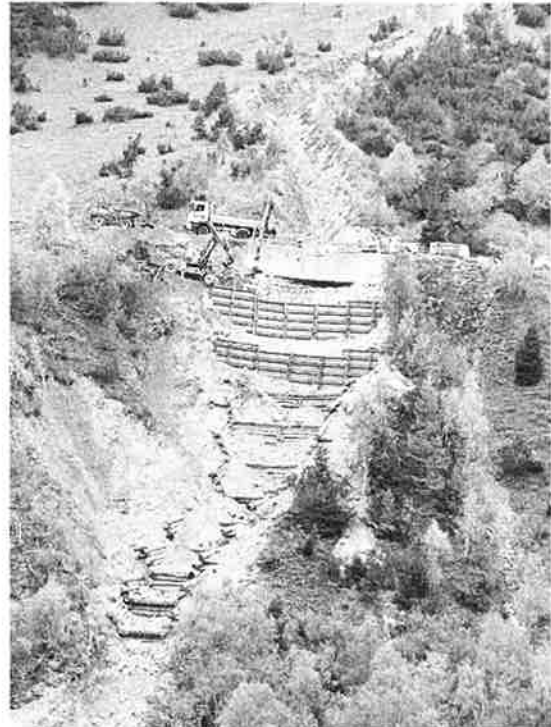
Furt Breitzug mit Ankerwänden und Holzkastenverbau
