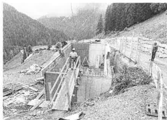
Löschwasserbecken im Bau, 7. Oktober
