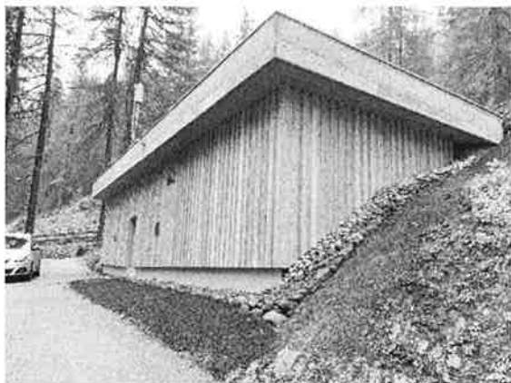
Der neue Hauptsammler Hochflüela konnte im Oktober in Betrieb genommen werden
