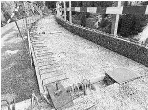
Vorgefertigte Betonelemente welche noch mit Beton eingedeckt werden
