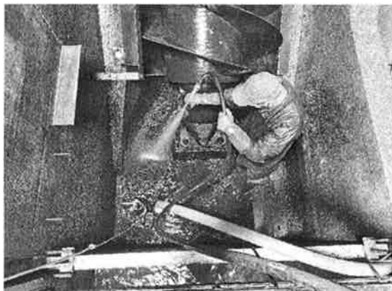
Vor der Revision werden die Anlagenteile gründlich gereinigt.
