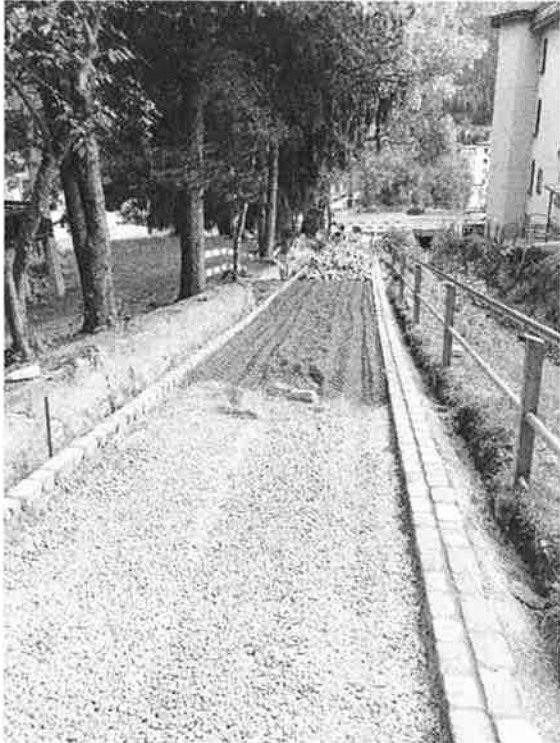
Pflasterung des Praviganwegs oberhalb der Oberen Strasse
