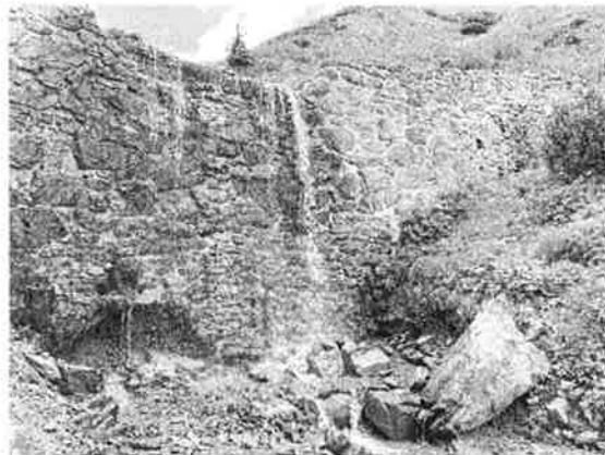
Blocksteinsperre im oberen Bereich mit Unter-spülung
