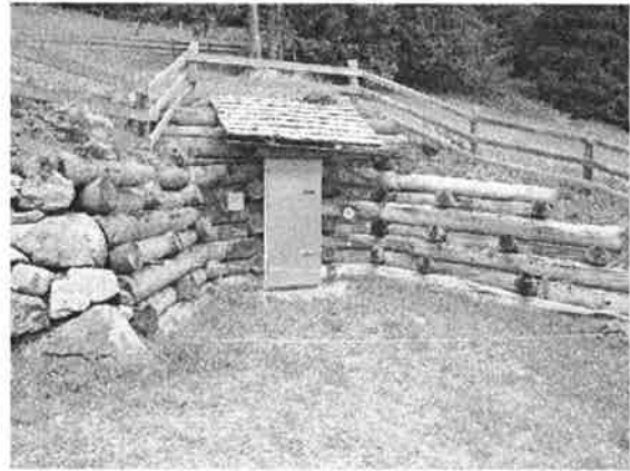
Die Zäune um die Reservoirre (im Bild Reservoir Grüeni) und Anlagen werden regelmässig kontrolliert und wenn nötig instandgestellt
