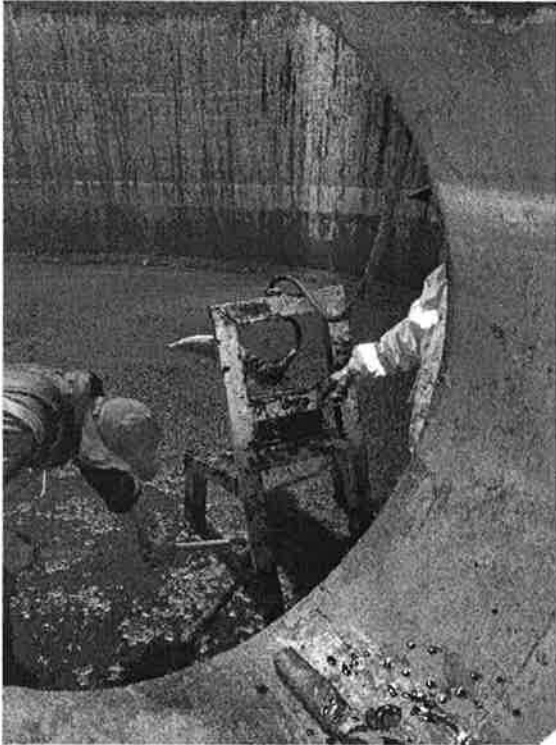
Kontrolle und Revision im Faulraum 2
