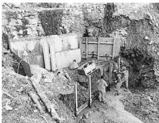
Blocksteinsperre unterfangen mit Beton, seitlicher Flankensicherung und Vorsperre mit Stahlkonstruktion
