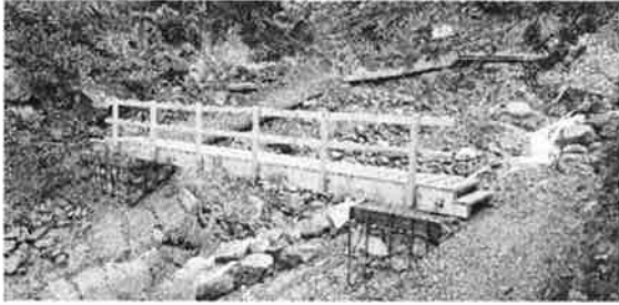
Brücke Platschtobel Wiesen
