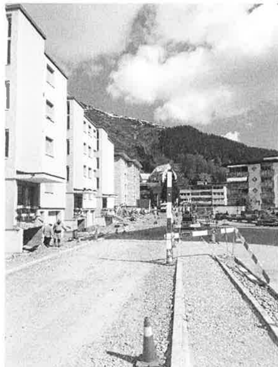
Randabschlüsse an der Seehornstrasse vor dem Belageeinbau
