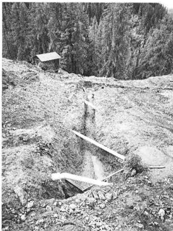
Umlegung der Kanalisation infolge privater Bautätigkeit in Davos Clavadel
