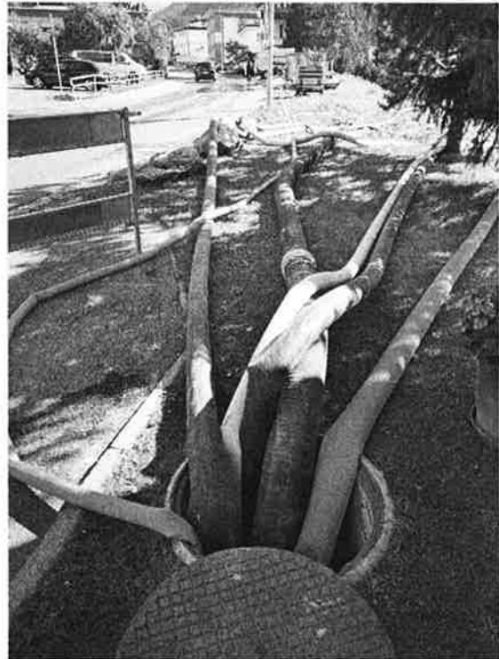
Aufwendige Wasserhaltung an der Talstrasse
