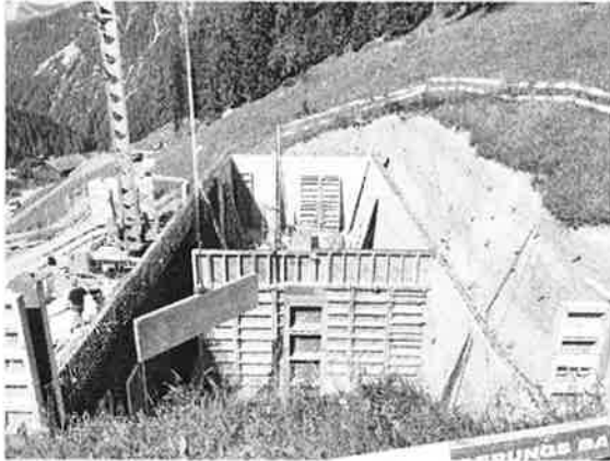
Neubau Reservoir Monstein, Rohbau und Baugrubensicherung
