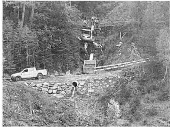
Sanierung der Blocksteinsperrn
