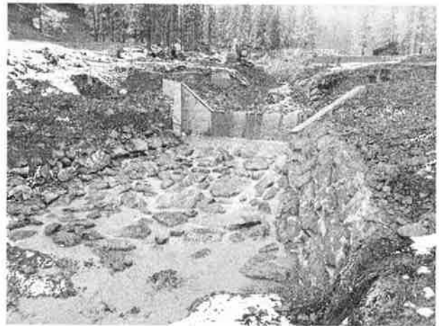
Erstellte Betonsperre, 23. November
