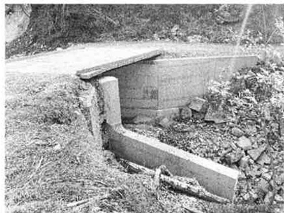
Sanierte Brücke über das Steigtobel
