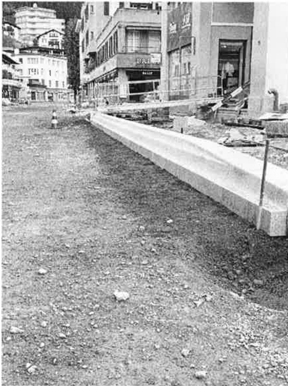
Hohe Haltekante an der Bushaltestelle Schatzalpbahn
