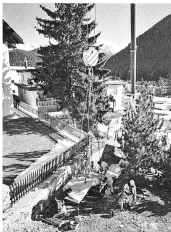
Setzen eines Treppenelements am Rütistutz
