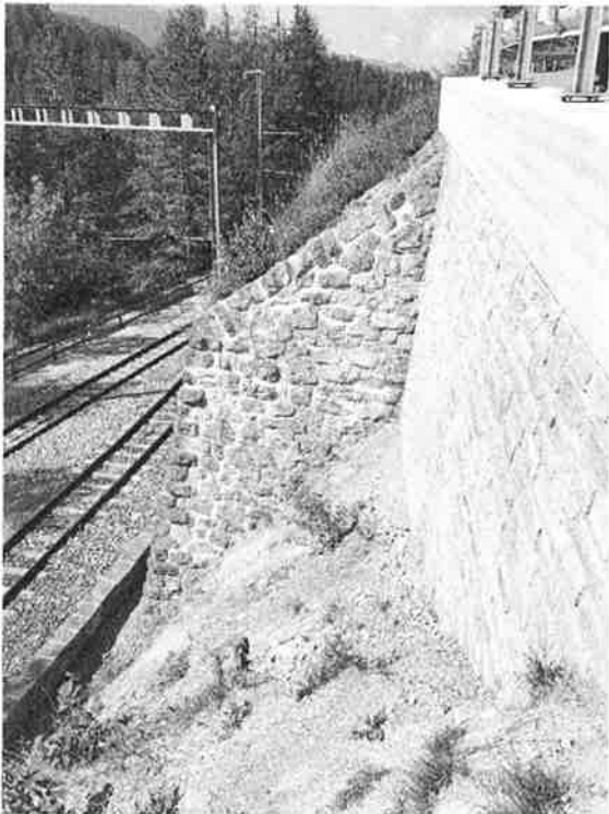
Ansicht der sanierten Stützmauer inkl. RhB-Geleise
