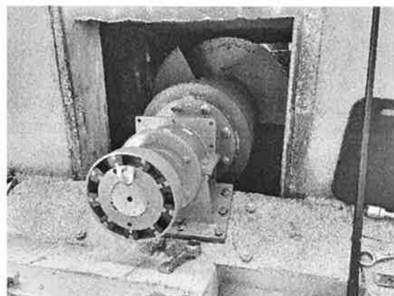
Einbau des neu revidierten oberen Lagers
