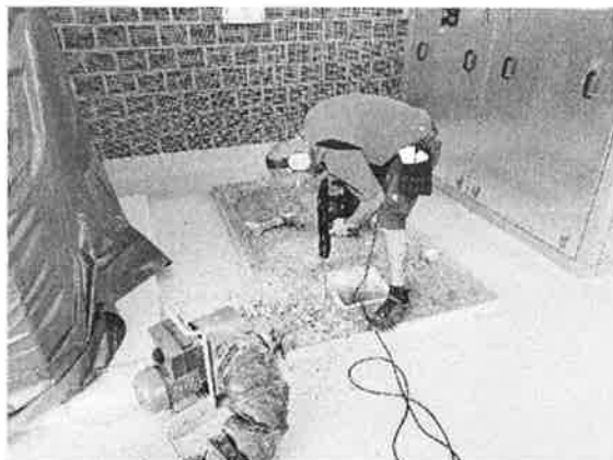
Rico Lehmann bei den Vorbereitungsarbeiten für das Setzen des neuen Schraubengebläses
