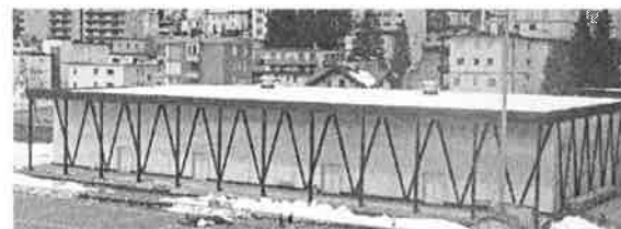
Dach des Trainingscenters am 25. April 2021
