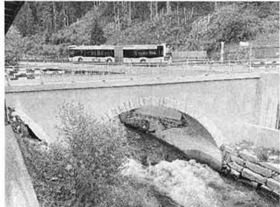
Ansicht der sanierten Bogenbrücke mit sichtbarem Natursteinbogen
