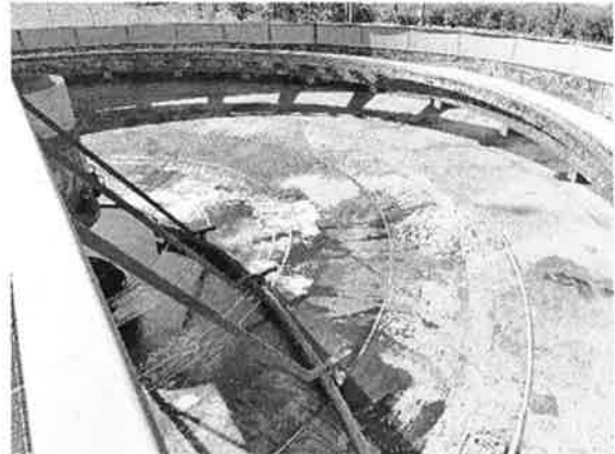
Abgelassenes und gereinigtes Nachklärbecken
