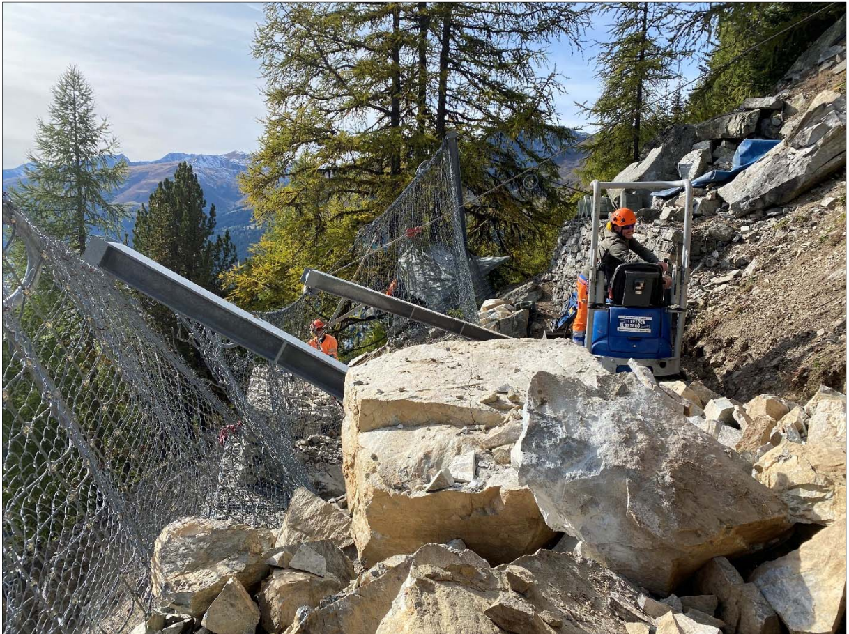
Räumungsarbeiten hinter dem teilweise zerstörten Werk Nr. 69
