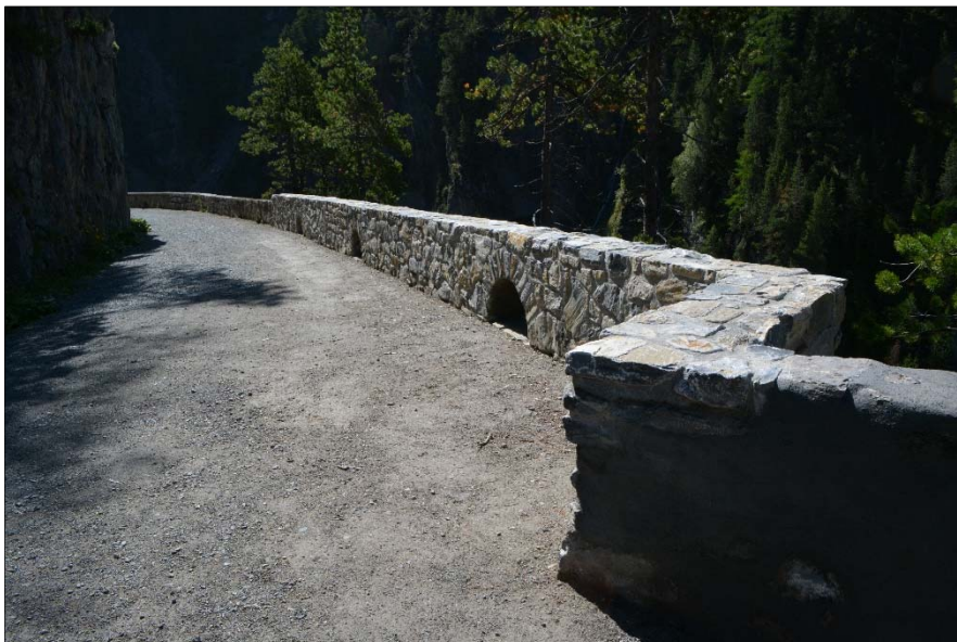
Erneuerung des Mauerwerks entlang der alten Zügenstrasse beim Bärentritt, Sommer 2020
