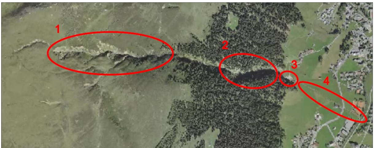
Bildjibach mit 1 Oberlauf Sperren 13 bis 22, 2 Mitte Sperren 4 bis 12, 3 Geschiebesammler und 4 Unterlauf. Bild: Technischer Bericht DIAG.
