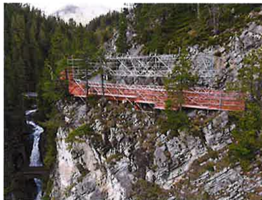
Baustelle alte Zügenstrasse
