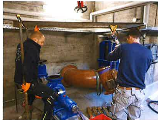
Ausbau alter Pumpen Jahrgang 1977
