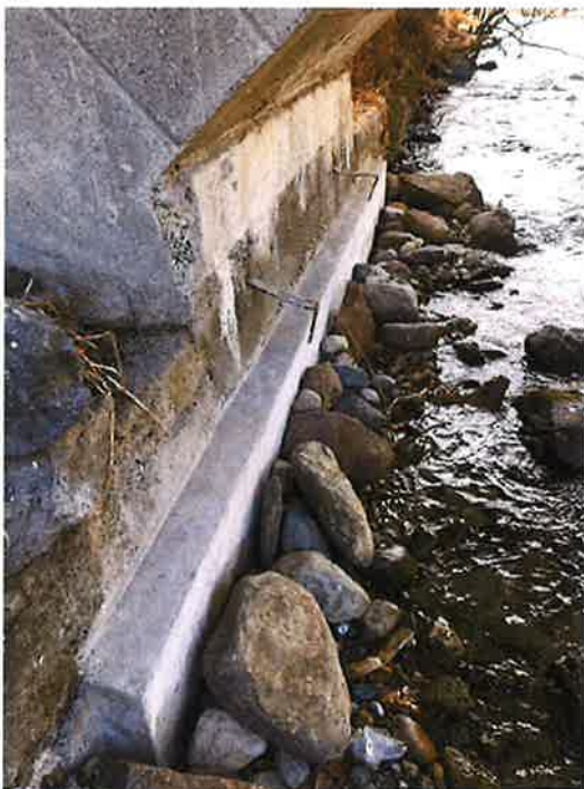
Sanierung Fundamente Brücke Sertigerstrasse
