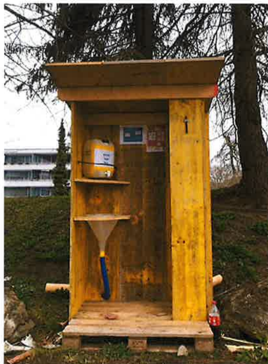
Corona-Waschstation auf Baustellen
