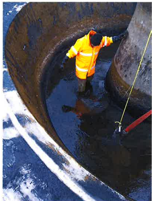
Blick in den Trichter Nachklärbecken I
