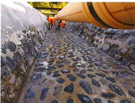
Im trockenen Kanal wurden die Mauerfugen an der Sohle und in den Seitenwänden frisch vermörtelt. (Foto DIAG)
