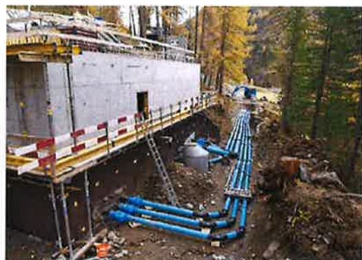
Rohbau Hauptsammler Hochflüela mit Leitungsbau.
