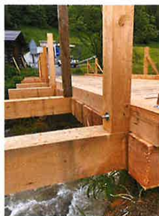
Brücke Ardüs (Foto MH)
