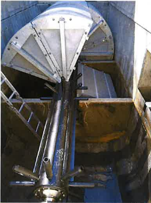
Einbau der neuen Scheibentauchtropfkörper in der ARA Wiesen
