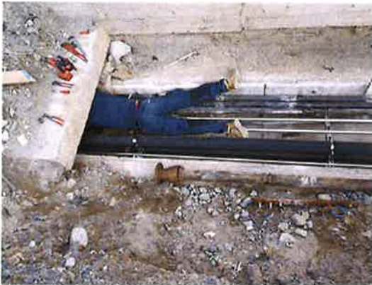
Einbauarbeiten der neuen Fernleitungen mit teils engen Platzverhältnissen
