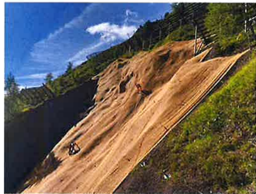
Verlegen und Befestigen des Kokosnetzes an der Netzabdeckung (Foto MH)
