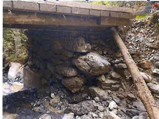
Brücke über das Steigtobel (Foto MH)
