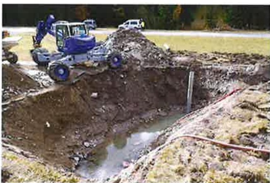
Standort des Entnahmehrunden und der Kiespackung beim Bau
