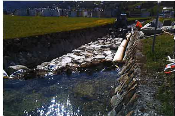
Sanierung Bachsohle mit Wasserhaltung (Bild Herzog Ingenieure)
