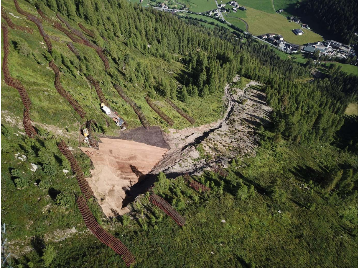
LV Duchli; Rutschung mit fehlenden LV-Werken und teilweise erfolgter Netzabdeckung (Bild P. Ebnetter, AWN)
