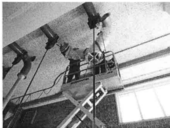
Umbau Gebläse ARA Davos
