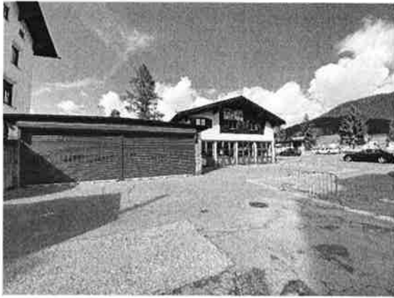
Feuerwehrgebäude Davos Dorf
