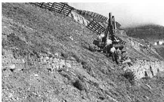
Erstellung von Steinkörben am Schiahorn
