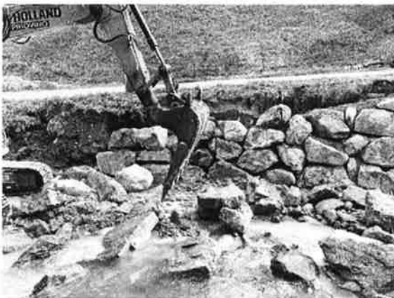
Für die Instandstellung der Wuhrung entlang des Sertigbachs wurden grosse Maschinen benötigt
