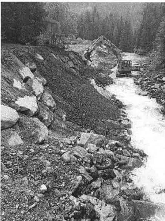
Böschungssicherungen mit Blocksatz im Unterlauf
