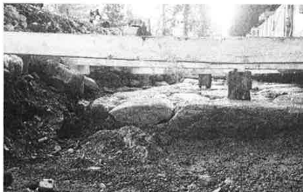
Sohlenpflasterung im Bau am 14. Oktober 2019
