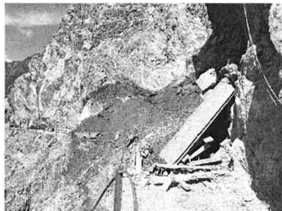
Sprengung der Galerien am Felsenweg
