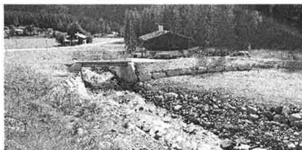
Zufahrt zu Liegenschaften 1897/1624 mit neuer Brücke
