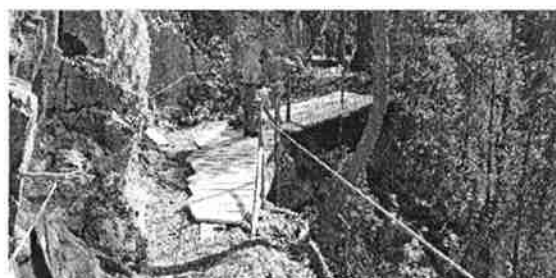
Brückenbau am Silberberg
