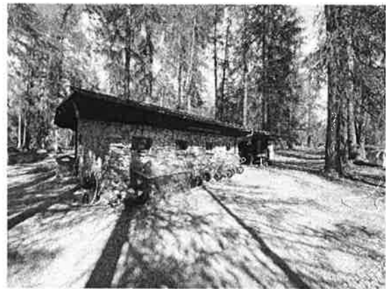
Werkgebäude auf dem Waldfriedhof
