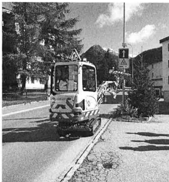
Standortsicherheitsprüfung durch die Firma SA-GA NDT AG an einem Kandelaber an der Talstrasse
