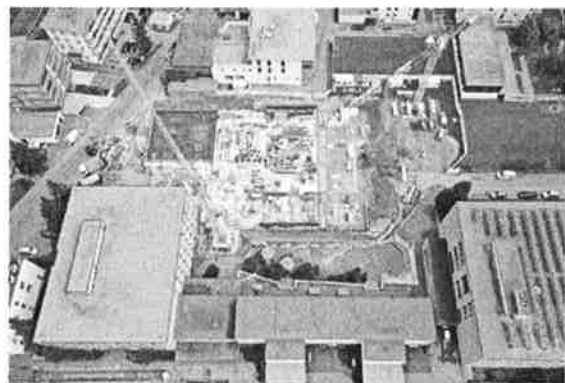
Baustelle 3-fach-Turnhalle Tobelmühle
