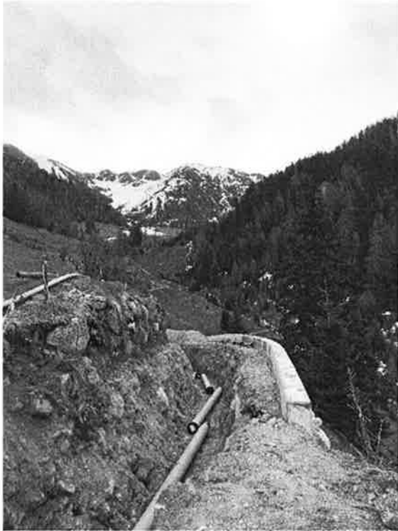
Verlegen der Trinkwasserleitung in die zu sanierende Forststrasse Richtung Oberalp
