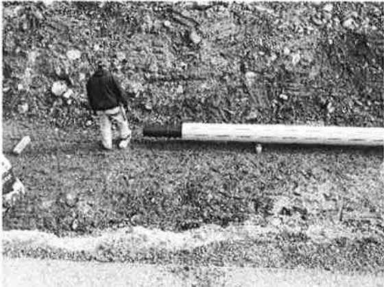
Doppelwandiges Kanalisationsrohr (schwarz = Kanalisationsrohr, hellbraun = Hüllrohr)
