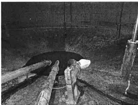
Entleerter Faulraum Nr. 1 mit Leitungen und Rührwerk
