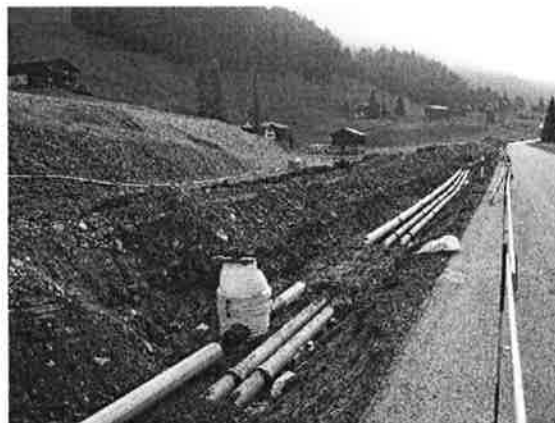
Erschliessung Sertig mit brauner Kanalisation neben den Trinkwasserleitungen
