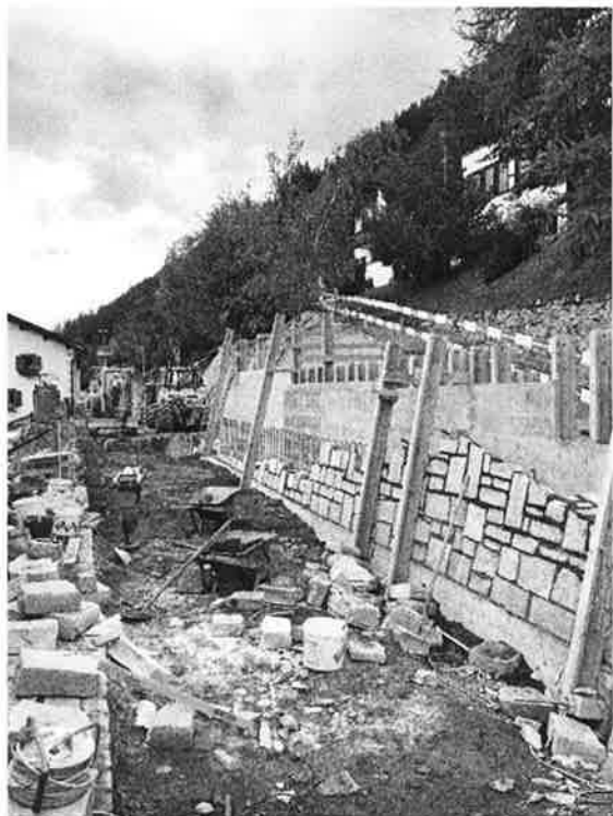
Neue Stützmauer an der Aussergasse Wiesen
