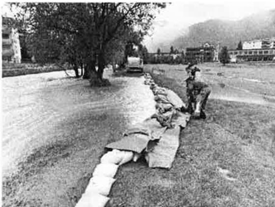
Mit Sandsäcken wird verhindert, dass das Wasser das Flussbett verlässt.
