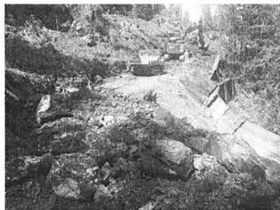
Waldweg Dürrwald im Bau
