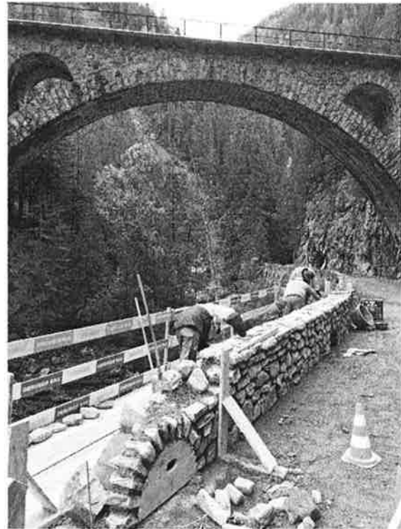
Sanierung der alten Zügensstrasse nach alter Strassenbaukunst
