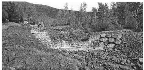
Sanierte Sperren im Oberlauf
