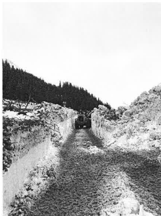
Aufwendige Schneeräumungsarbeiten zur Öffnung der Dischmastrasse im Mai 2019
