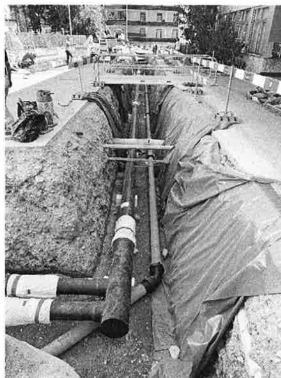
Neu verlegte Trinkwasserleitung (blau) neben der Fernwärmeleitung in der Schulstrasse
