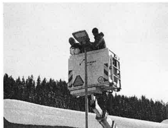
Auswechseln der alten Beleuchtung auf LED-Leuchten in Zusammenarbeit mit dem EW Davos
