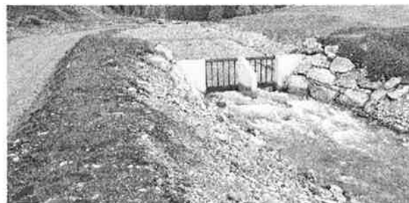
Gerinneaufweitung mit Auslaufbauwerk
