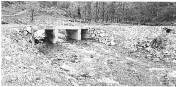
Brücke über den Chüealpbach
