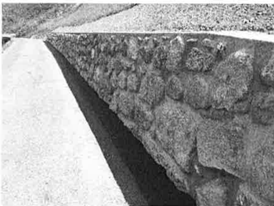
SIE Silberberg sanierte Mauer
