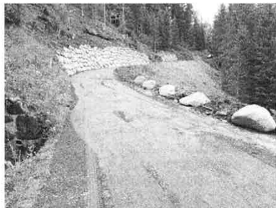
Waldweg Knochenmühle - Heidboden nach der Instandstellung
