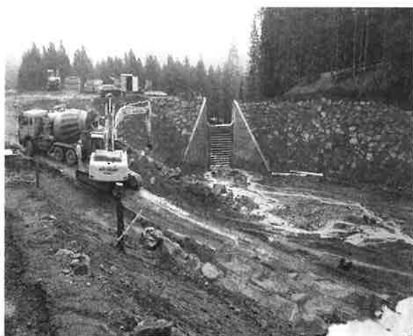
Bauarbeiten am Geschieberückhaltebecken
