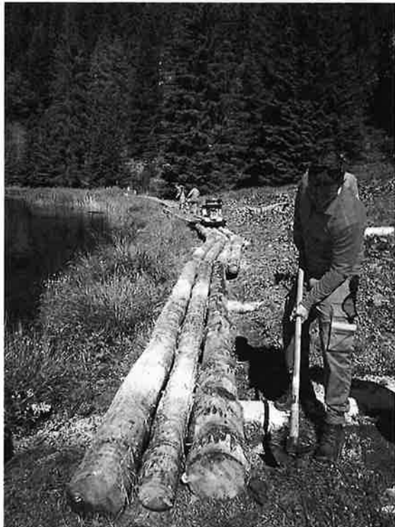
Arbeiten an Wanderwegen
