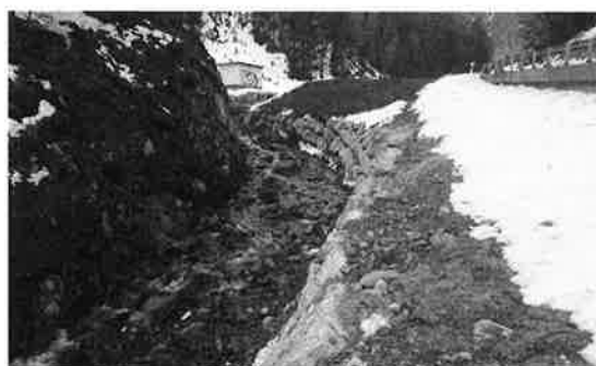
Ufersicherung entlang der Kantonsstrasse
