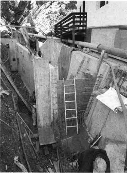
Bauarbeiten am Einlaufbauwerk
