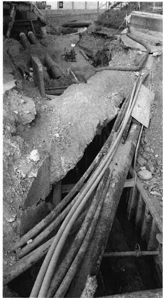
Bachkanal und Werkleitungen bei der Vaillant-Arena
