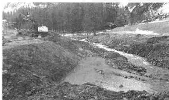
Bauarbeiten für Geschiebesammler
