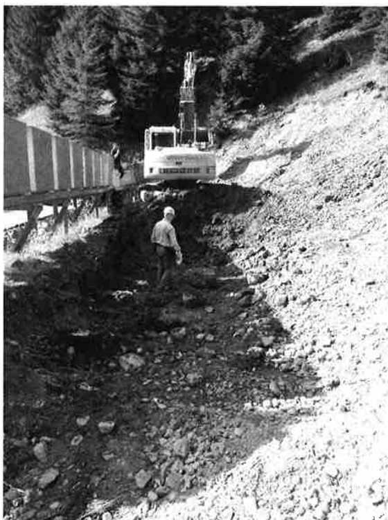
Sanierung Kugelfang Jagdschiessanlage
