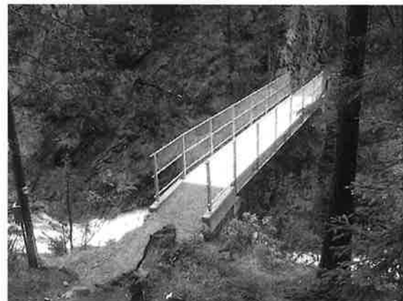
Neue Brücke beim Bärentritt
