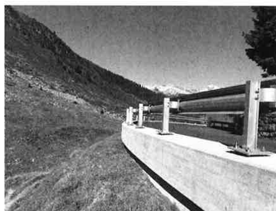
Erneuerung Stützmauer Sertigerstrasse
