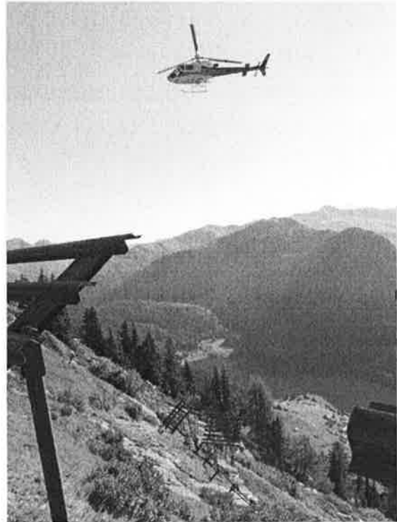
Montage der Stahlschneebrücke in der letzten Werkreihe
