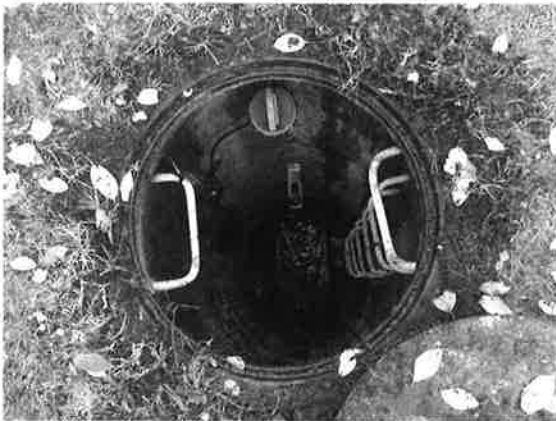
Eingebauter Prozesswächter mit Sender und Sensor
