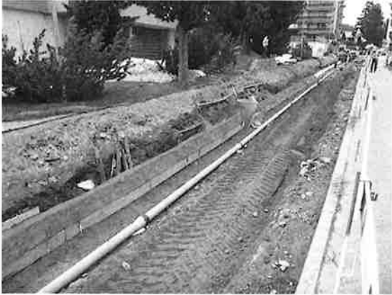
Neu verlegte Trinkwasserleitung in der Oberen Strasse
