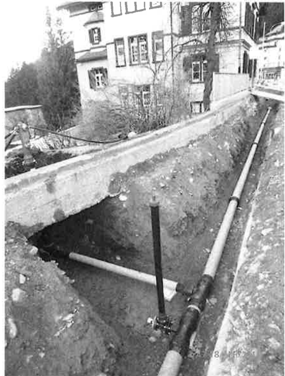
Neue Leitung in der Promenade mit Hydrantenanschluss und Schieberstange für den Anschluss des Bärenbrunnens im Kurpark
