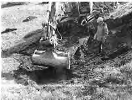
Abtrag des mit Blei kontaminierten Bodens
