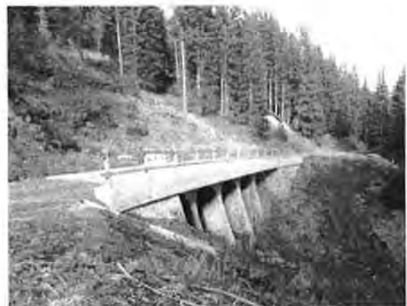
Bobbahnstrasse, Brücke Rütibach (Foto H. Hefti)
