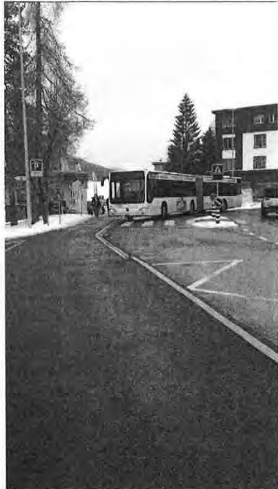
Ansicht des neu gestalteten Postplatzes mit Mittelinsel am Fussgängerstreifen und Trottoirüberfahrt in Richtung Silvretta-Zentrum
