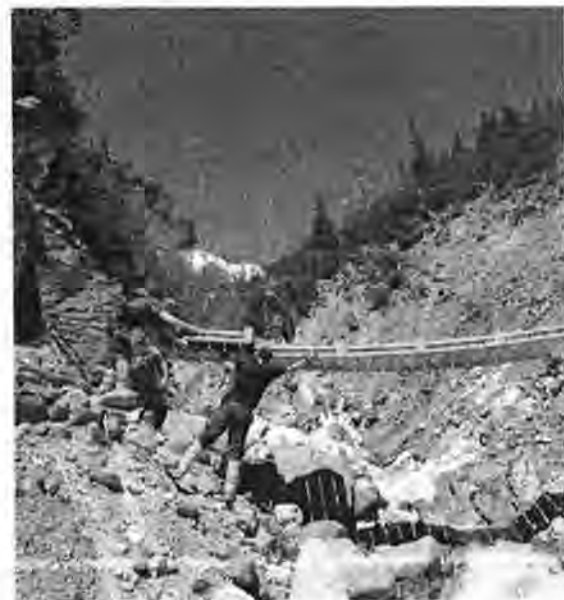
Brückenmontage im Platschtobel
