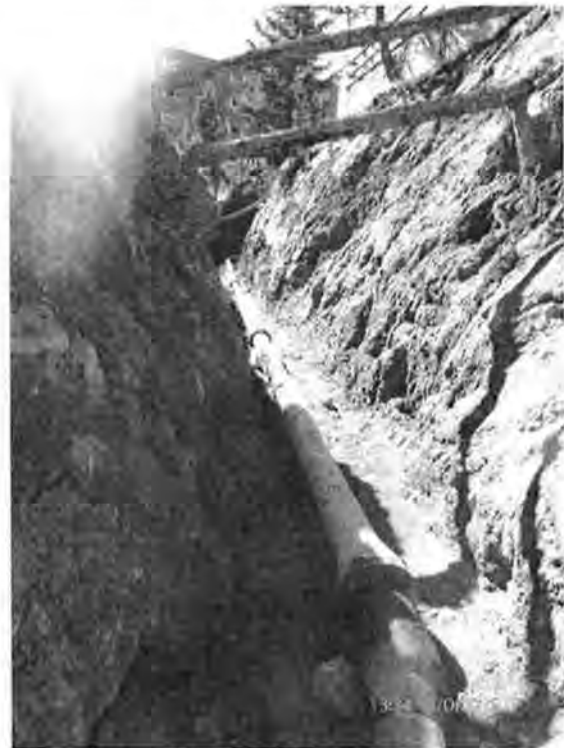
Umgelegte Trinkwasserleitung unter bestehenden Werkleitungen
