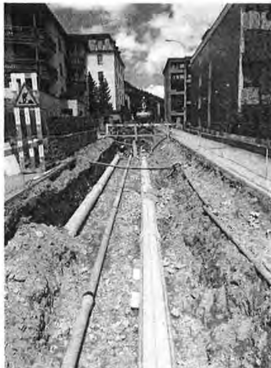
Neu verlegte Werkleitungen
