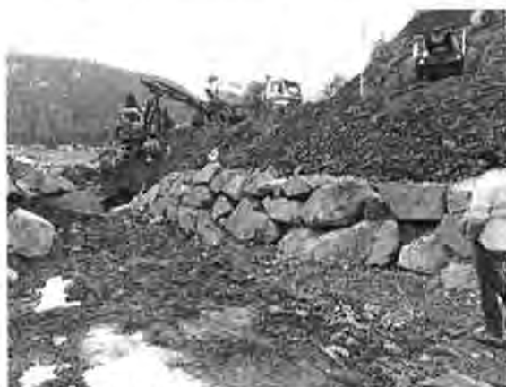
Aufbau der Blocksteinmauer (Foto R. Morell)
