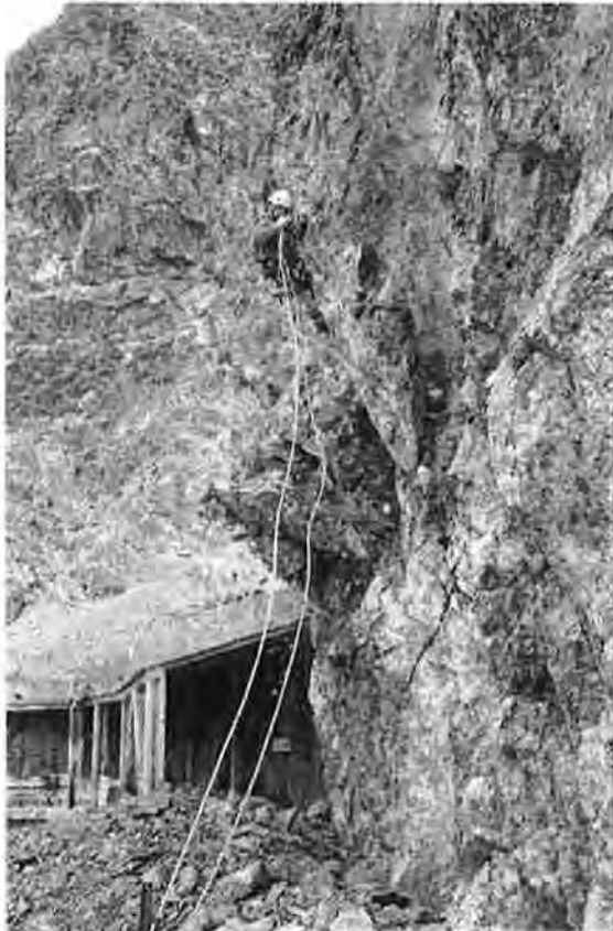
Sprengung beim Felsenweg
