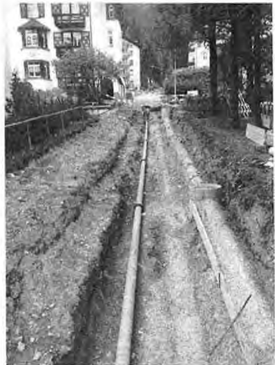
Neue Trinkwasserleitung in der Edenstrasse
