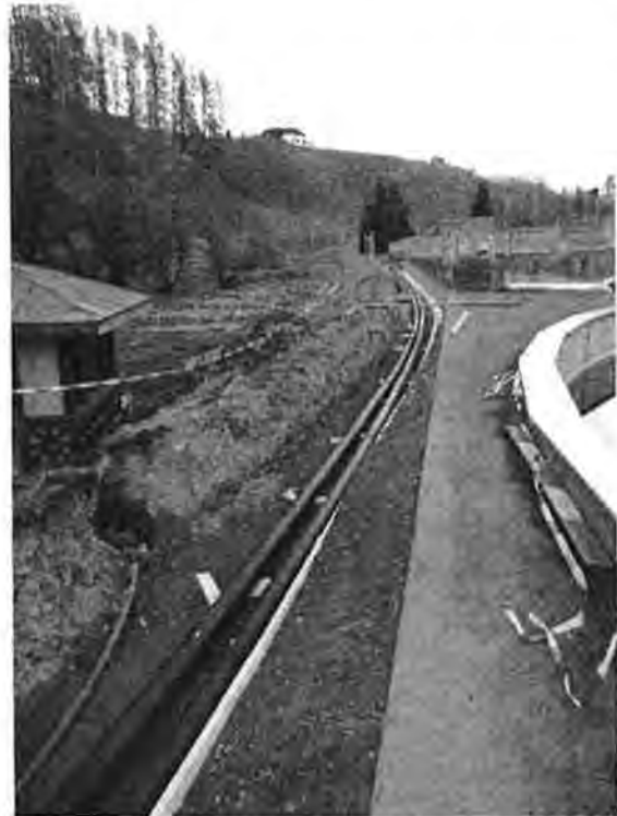
Verlegung der beiden Glykoleitungen für den zukünftigen Wärmetransport in Richtung Wärmepumpen
