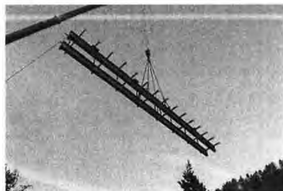
Eine Hälfte des neuen Brückenunterbaus wird 'eingeflogen'
