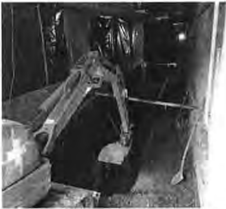
Ersatz einer eingestürzten Schmutzwasserleitung
