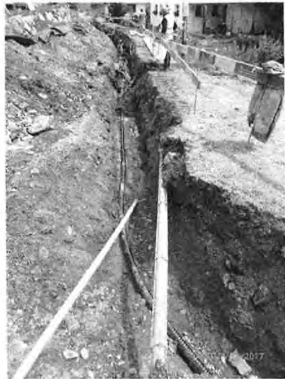
Erschliessungsleitung im Quartier Büelen
