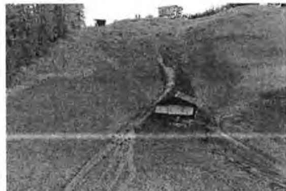
Erdbeben nach Leckage der Transportleitung Sertig
