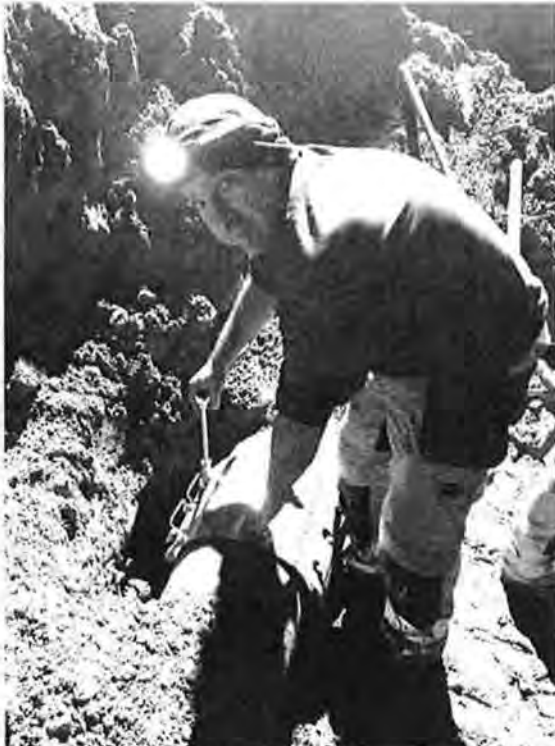
Nachteinsatz eines Mitarbeiters der Wasserversorgung Davos zur Reparatur der Leckage
