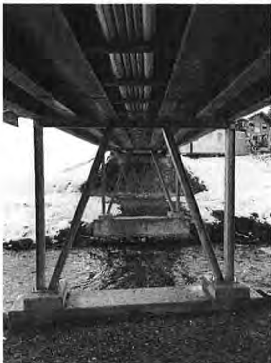
Untersicht der sanierten Brücke inkl. Auflagefundamenten
