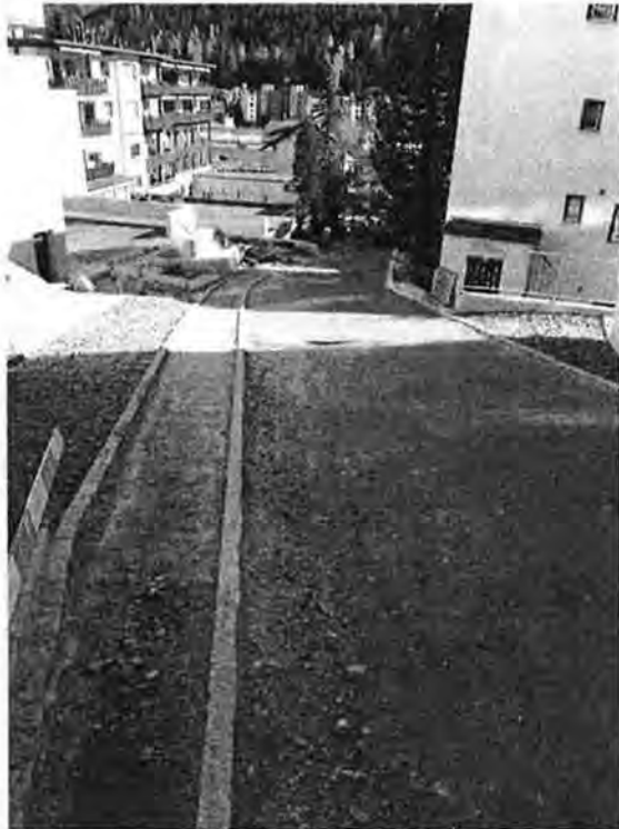
Sportweg vor Belageeinbau mit Trottoir
