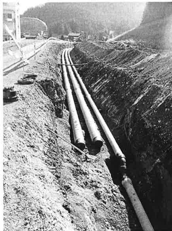
Ansicht der neuen Leitungen im Bereich des Bedrawegs. Die beiden grossen Leitungen
