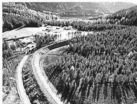
Arelenbach, Geschieberückhaltebecken, Ende Oktober 2015
