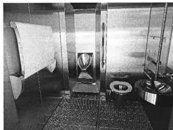
Abbruch der alten WC-Anlage und Neubau mit drei modernen Modulen
