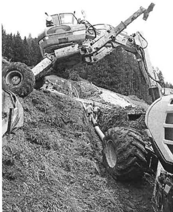
Die neue Transportleitung im steilen Leitungsgraben. Von den Maschinisten war besonderes Geschick gefordert.
