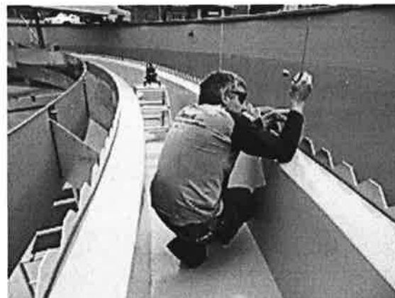
Firma Tinner GmbH bei der Höhenkontrolle der Zackenbleche.
