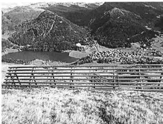
Lawinerverbauung Dorfberg, fertig montierte Stahlschneebrücken
