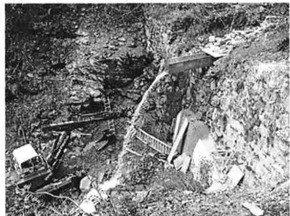
Bildjibach, Aushubarbeiten für die Sanierung einer Sperre
