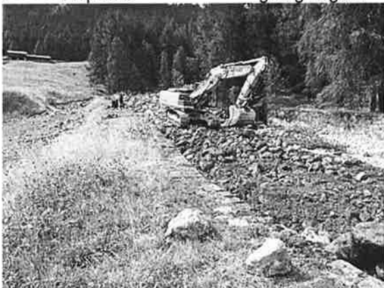
Stützalpbach, Räumungsarbeiten bei der Wasserfassung
