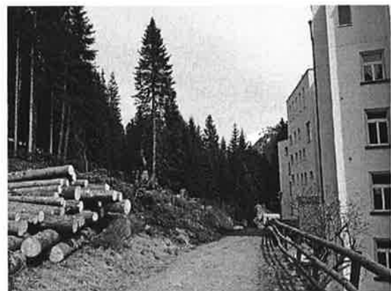
Holzereiarbeiten an der Hohen Promenade
