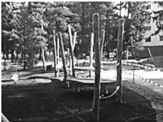
Bau der neuen Spielgeräte mit entsprechenden Fallschutzmassnahmen
