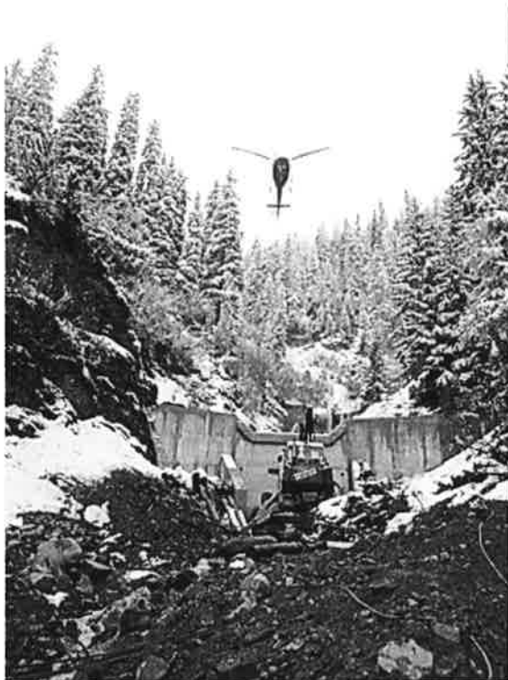
Bildjibach, Materialtransporte für die Sperrensanierung
