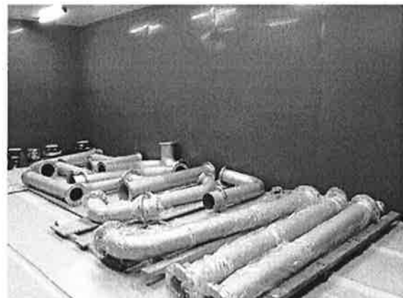
Die Leitungen liegen bereit zum Einbau
