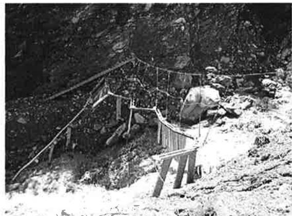
Hängebrücke im Platschtobel nach Unwetter
