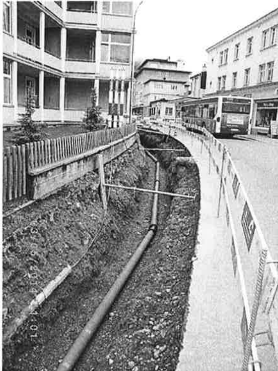
Einbau der neuen Wasserleitung im Trottoir im Bereich der Promenade 109
