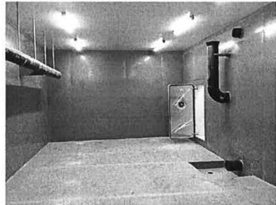
Fertiggestellte Reservoirkammer mit Etertub-Auskleidung
