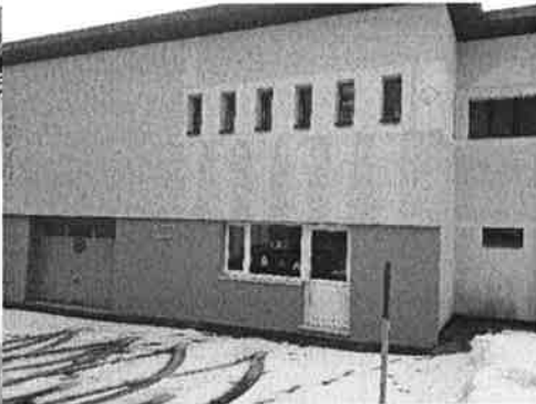
Neues Fenster mit Fluchttüre
