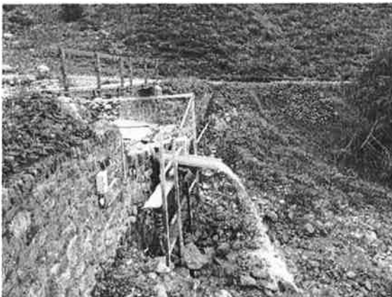
Sperrensanierung unterhalb der Lochalpstrasse (S. Riedi)
