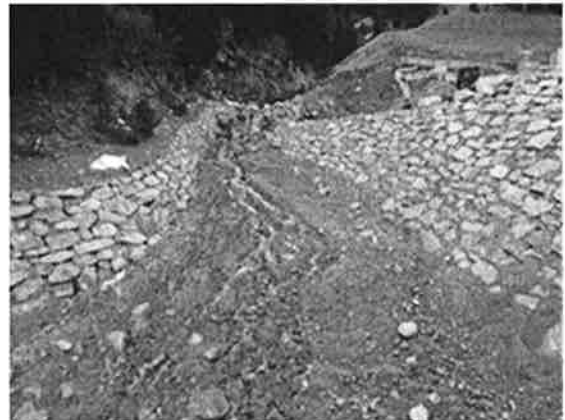
Blick vom Auslaufbauwerk in Richtung der Einlaufsperre (A. Fehr)
