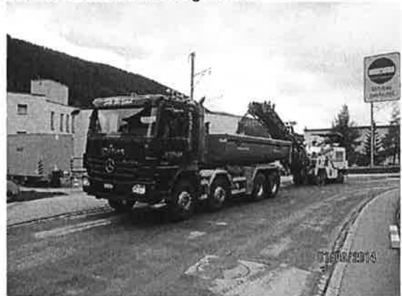
Belagsfräsarbeiten an der Talstrasse
