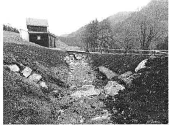
Statt einem engen Kanal präsentiert sich ein offenes Gewässer (P. Buol)
