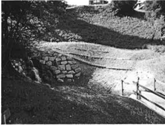
Geschiebesammler Grünenibach mit Einlauf-sperre (links) und Auslaufbauwerk (rechts) (A. Fehr)
