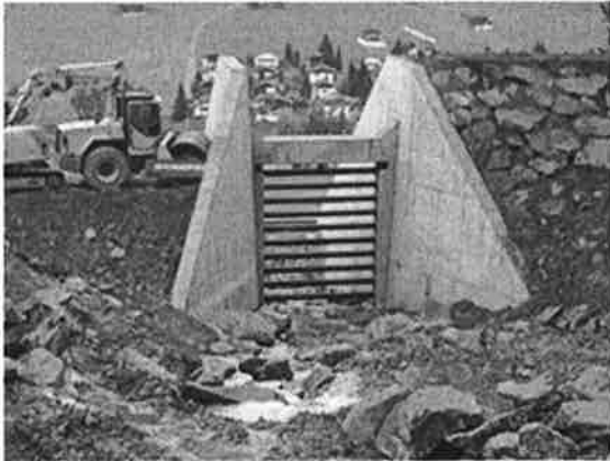
Auslaufbauwerk Geschiebesammler Bildjibach (A. Fehr)
