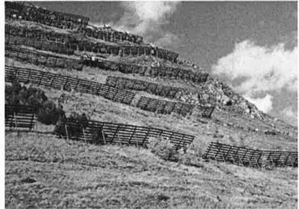
Auf der rechten Seiten die neuen Stahlschneebrücken (A. Guler)
