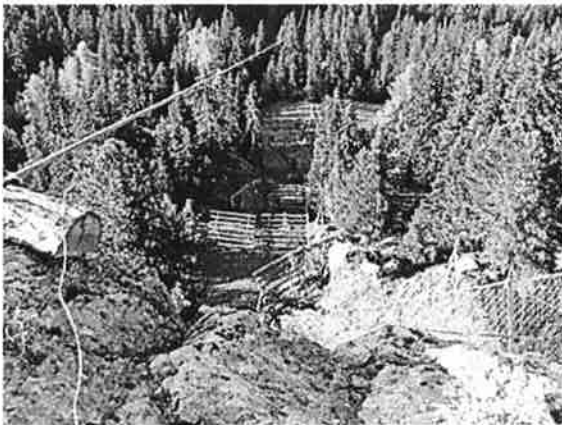
Seilkran über der Baufläche in der Lawinenverbauung Seehorn mit den neuen Verbauungswerken „rempar Grischun“ (H. Hefti)
